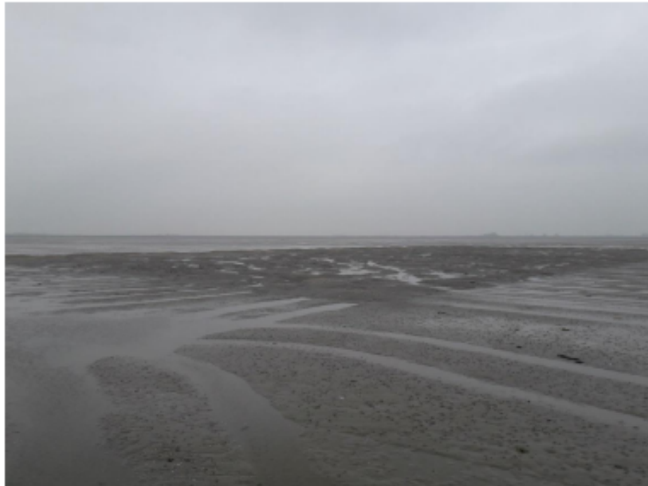
Primevak 3 na aanbrengen en enkele getijden. Te zien zijn ook de sporen van de shovel naar het primevak toe.
