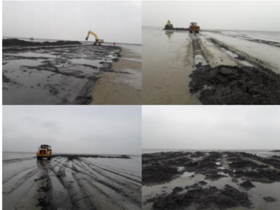
Priming vak 2, op slappe bodem. Aanvankelijk was de primelaag minder dik, omdat de shovel halve laadbakken gebruikte. Later is dit door de kraan aangevuld.
