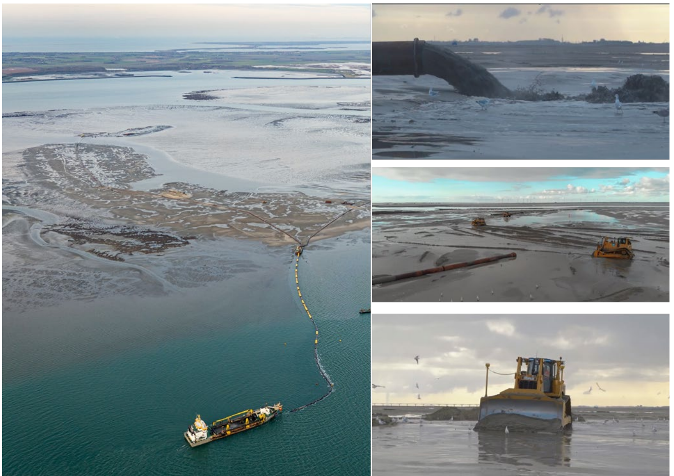
Figuur 4-2 Sleephopperzuiger aangekoppeld aan persleidingen (links), zand dat geperst wordt naar de suppletieplaats (rechtsboven) en bulldozers die het zand verplaatsen (rechtsmidden en -onder). Linker foto: Edwin Paree, Rechter foto's: beelden uit de video "Zeeuwse Roggenplaat: wegrestaurant voor trekvogels" RWS.
