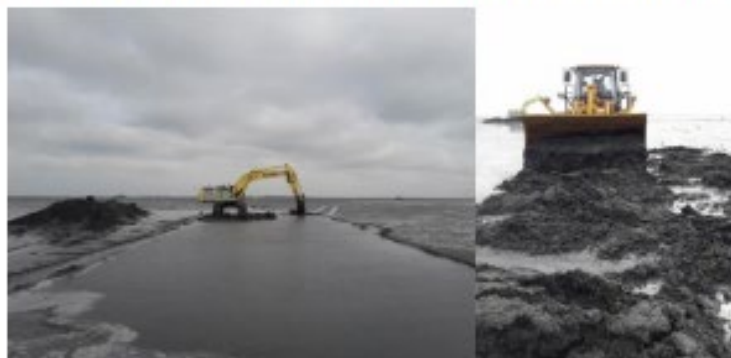
De toplaag wordt een een rug gelegd, waarna de shovel deze uitspreidt op het primevak.
