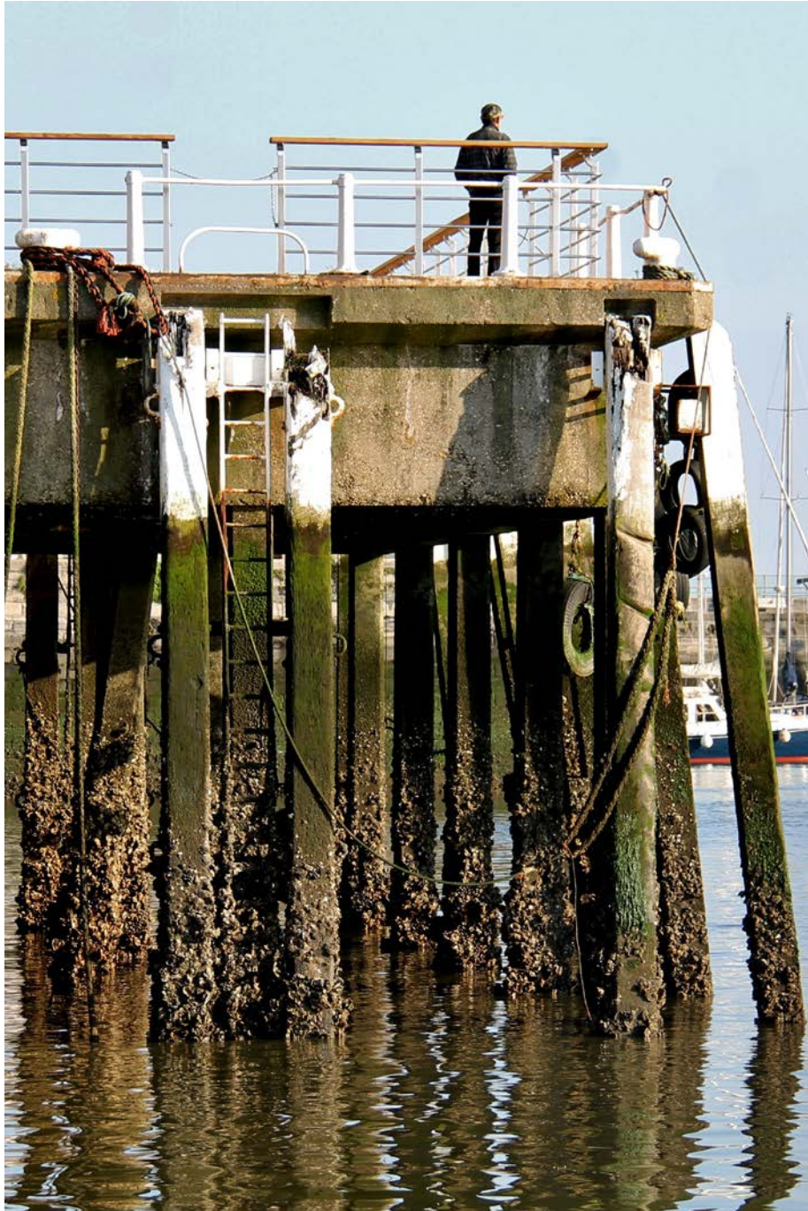
Foto 1: Aangroei van Crassostrea gigas aan de kaaimuren in de voorhaven van Oostende (augustus 2014). © VLIZ
