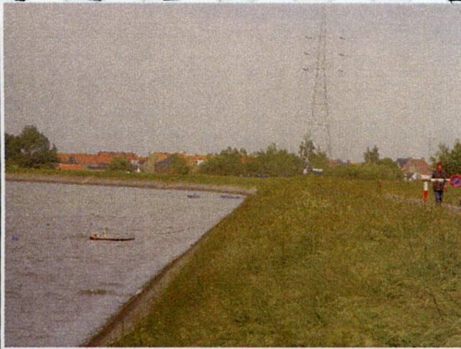
GLOOIING AAN DE ZUIDKANT VAN DE SPUIKOM
