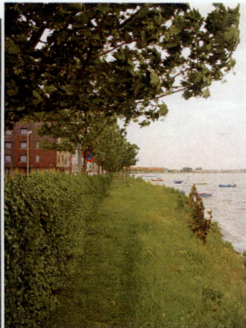
GLOOIING AAN DE NOORDKANT VAN DE SPUIKOM
