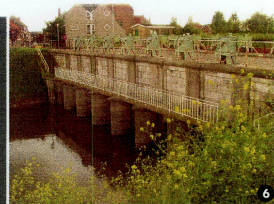
Foto 6: Stuw op de Noord-Ede aan de niet-tijgebonden zijde
