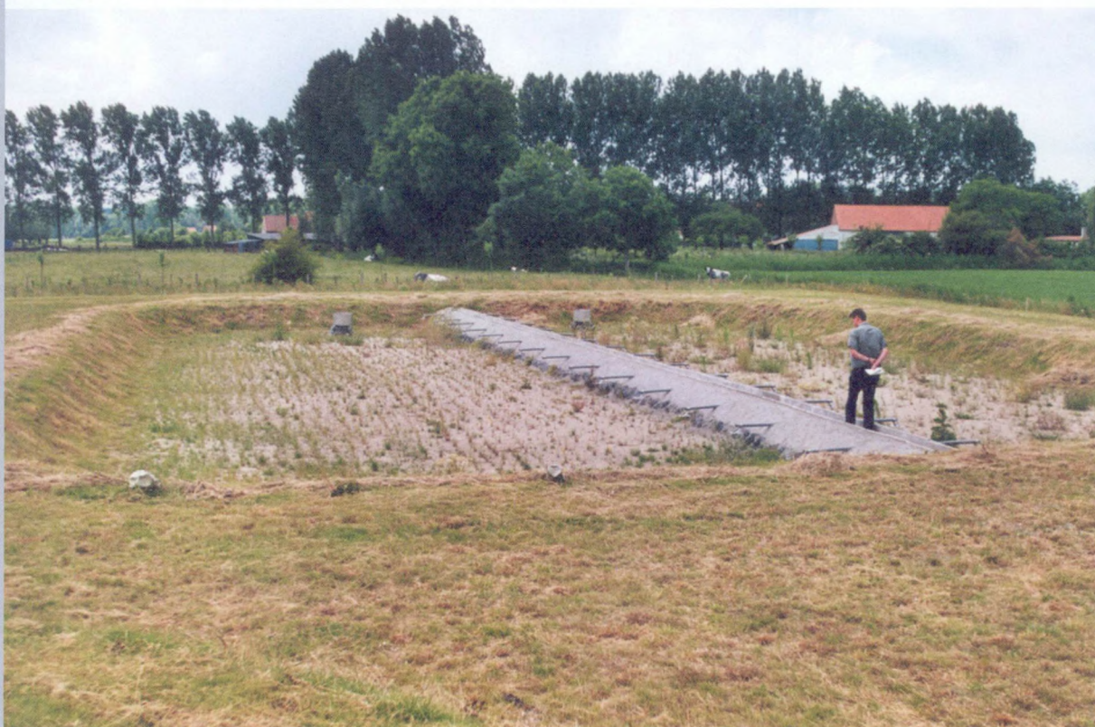
Aanleg van kleinschalige waterzuiveringinstallatie (KWZI) te Middelburg
