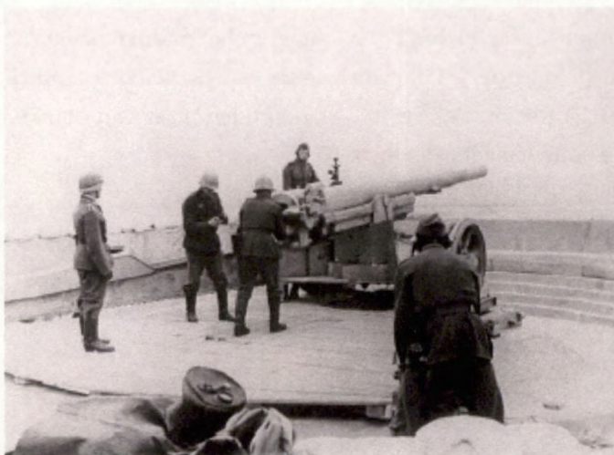
Figuur 2.13. De open bedding werd gebruikt als lanceerplatform voor de Franse kanonnen type 15,5 cm K 418 (f).
