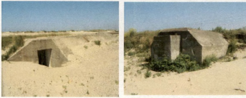
Figuur 2.6. Manschappenverblijf buitenkant: links de ingang en rechts de nooduitgang
