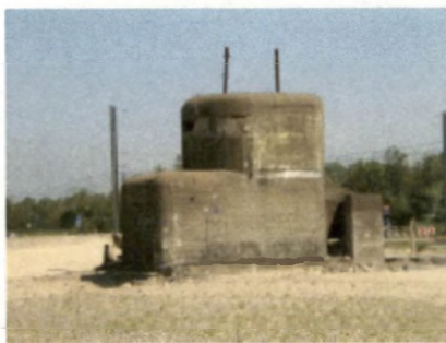
Figuur 2.4. Vuurleidingspost buitenkant
