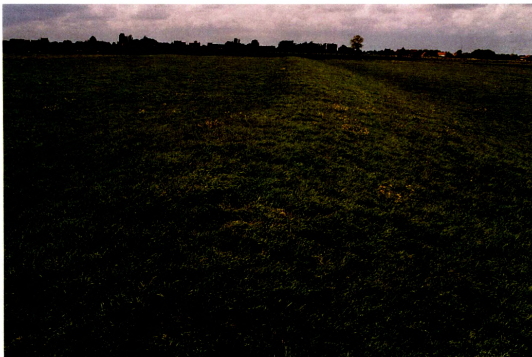
Fig. 4: Beeld van het dijkrelict in zone 2, kijkend naar het westen. Van links naar rechts zijn alle essentiële elementen van een dijk te zien: hiel, kruin, teen, karreveld voor de dijk, ongeroerde grond. Bemerkt ook het typische asymmetrische dijkprofiel, met het meest glooiende talud steevast naar het water gekeerd, hier is dit duidelijk vanuit het noorden te duchten geweest.
