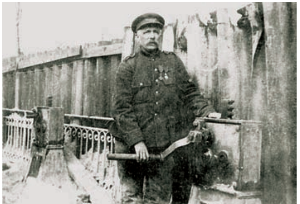
■ Hendrik Geeraert posiert bei einem der Zahnradkästen am Überlauf des Kanals Noordvaart (Sammlung Callanaere-Dehouc)
