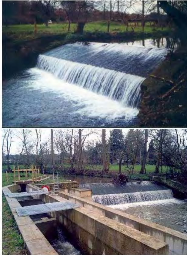
Figuur 34. Le barrage de Mortroux sur la Berwinne avant et après son équipement avec une échelle à poissons (canules).
