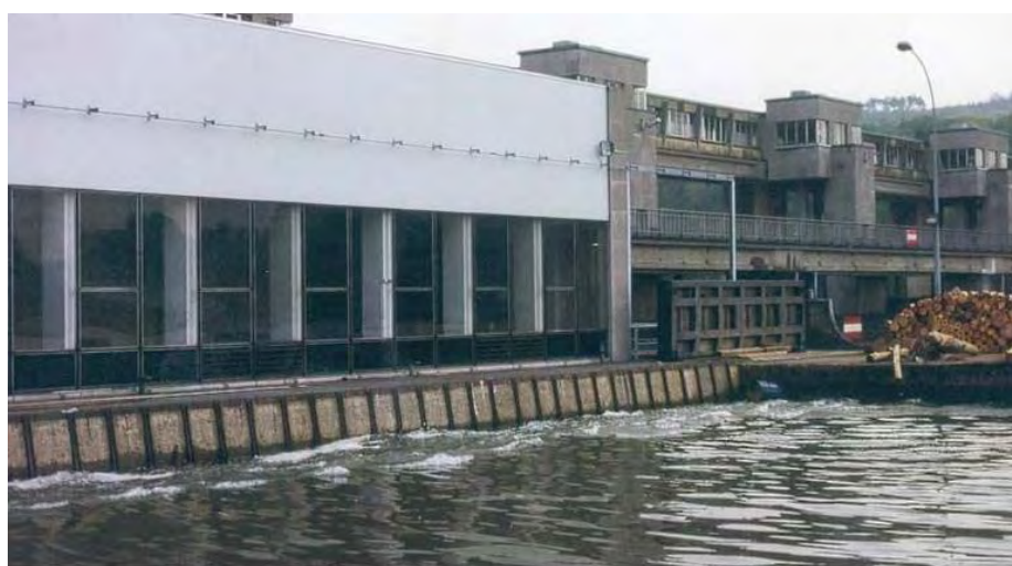
Figur 36. Prise d'eau de la centrale hydroélectrique de Monsin sur la Meuse
