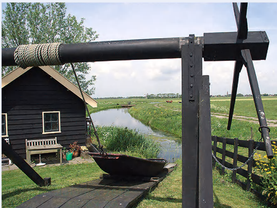
Deze moderne overtoom in het Hollandse Rijkswateringen geeft mooi aan hoe deze voorloper van het sas functioneerde om kleinere schepen met platte bodem verschillen in waterniveau te laten overbruggen (wikimedia).
