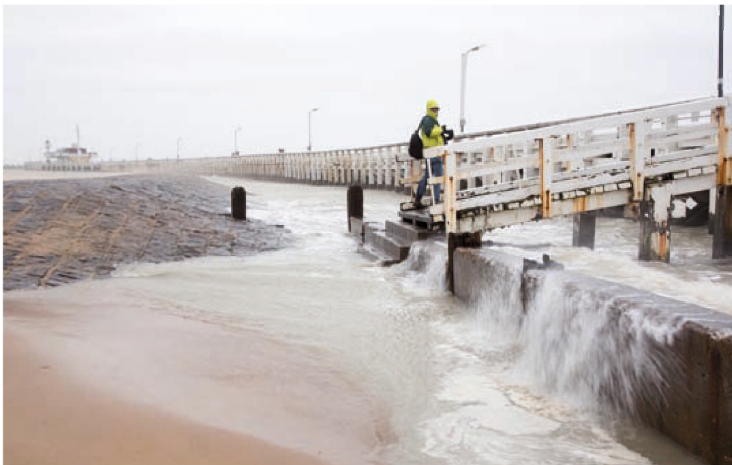
■ Op 5 december raasde er een storm over ons land met een kracht van 9 Beaufort op zee en rukwinden tot 97 km/u. In Oostende werd, met +6,3m TAW, die dag de hoogste waterstand gemeten sinds de stormvloed van 1953 (een 250-jarige storm: +6,6m TAW). De dijkhoogte in Oostende (+9,4m TAW) is ruim voldoende om de stad te beschermen tegen een 1000-jarige storm. Bij de bouw van een energie-eiland op zee volstaat een bescherming tegen een 250-jarige storm (VLIZ)
