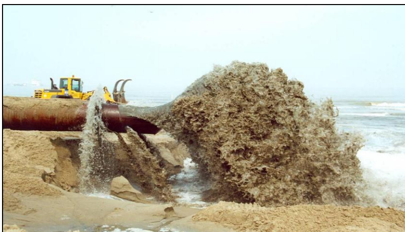
Foto: opspuiten strand De Haan
