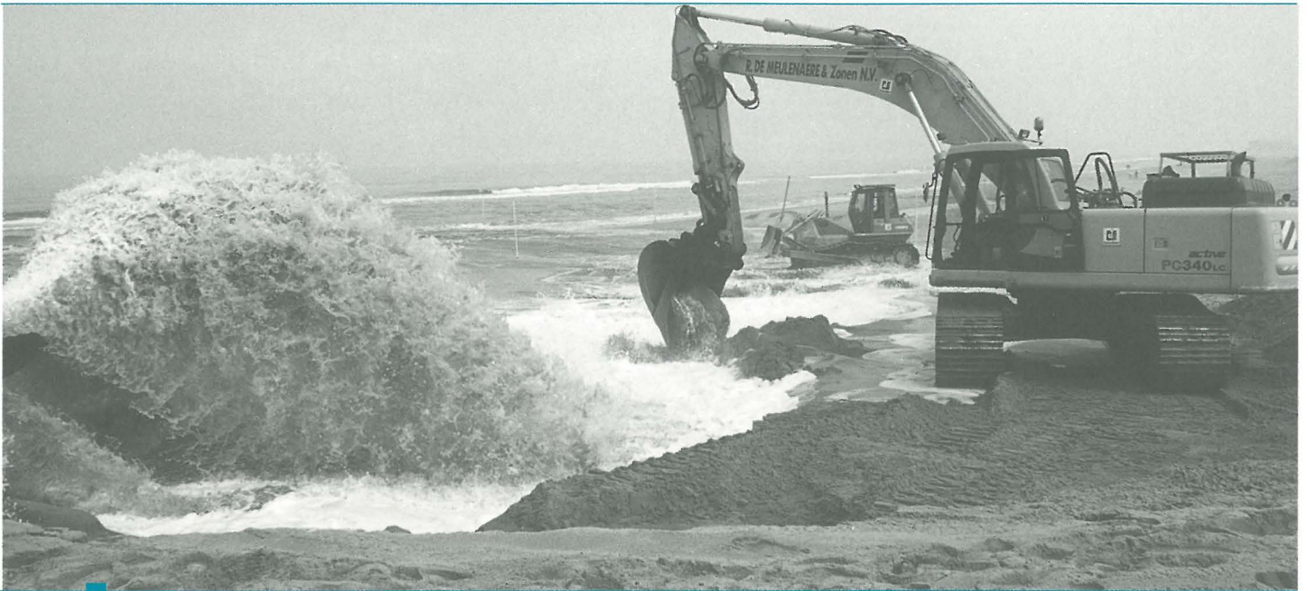
WWK Kranen en bulldozers rijden af en aan op het strand om het opgespoten zand optimaal te verdelen
