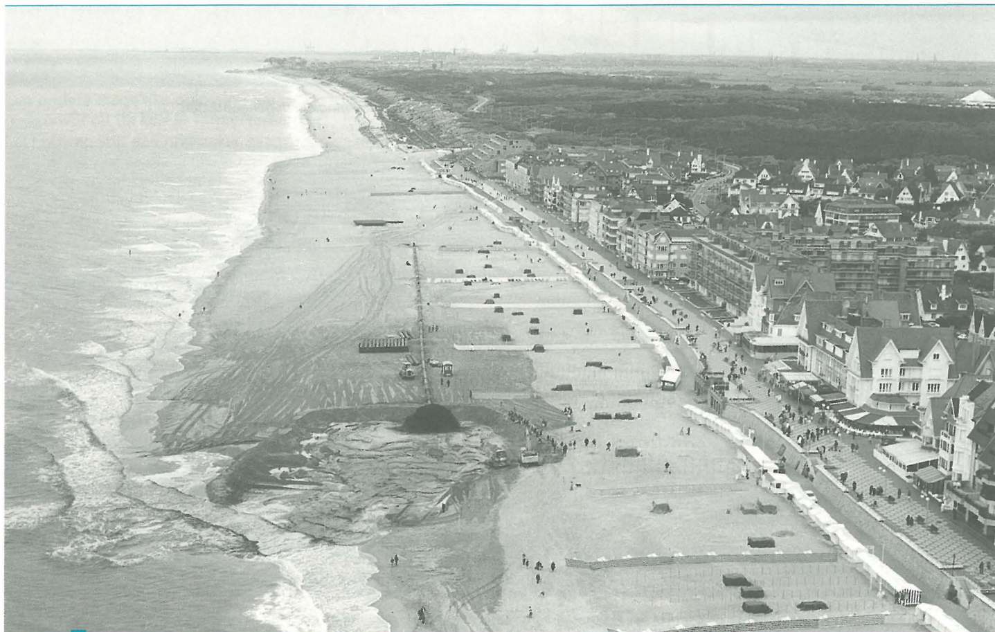
WWK ■ In De Haan werd anno 2000 het strand kunstmatig verbreed d.m.v. uitgebreide zandopspuitingen. Het zand werd door de sleephopperzuiger Vespucci gebaggerd in de vaargeulen naar onze havens toe en vervolgens met een persleiding naar het strand gepompt
