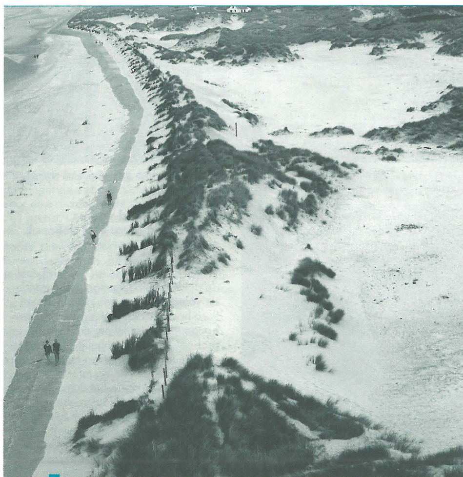
WWK Ter hoogte van het Westhoekreservaat (De Panne) is een harde duinvoetversterking aanwezig
