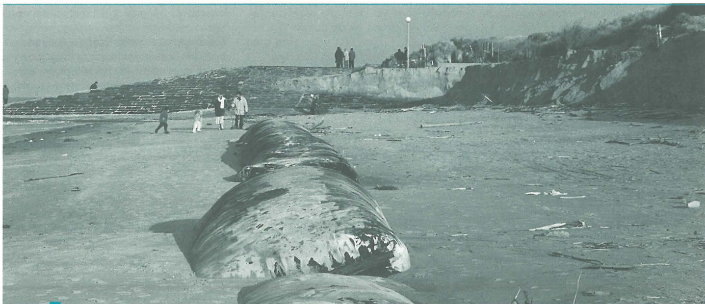
WWK ■ Om het zand beter vast te houden, wordt het ook wel eens opgespoten in een matrix van geotextielbuizen. Deze techniek is (gelukkig genoeg) nooit echt succesvol gebleken aan onze kust
