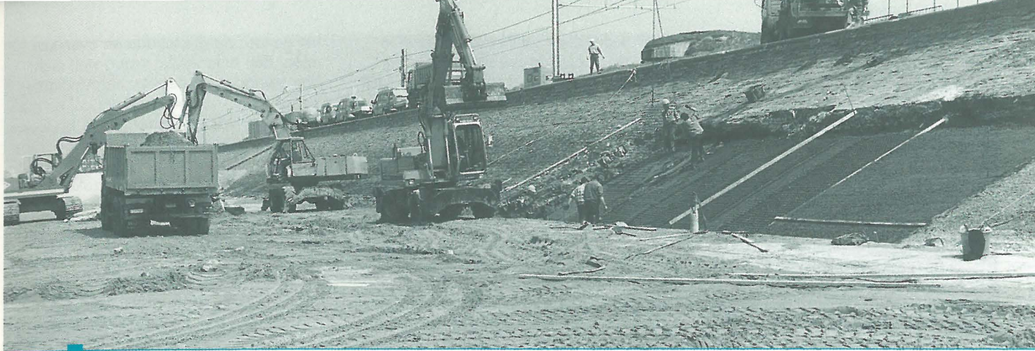
WWK Herstelwerkzaamheden aan de dijk van Raversijde
