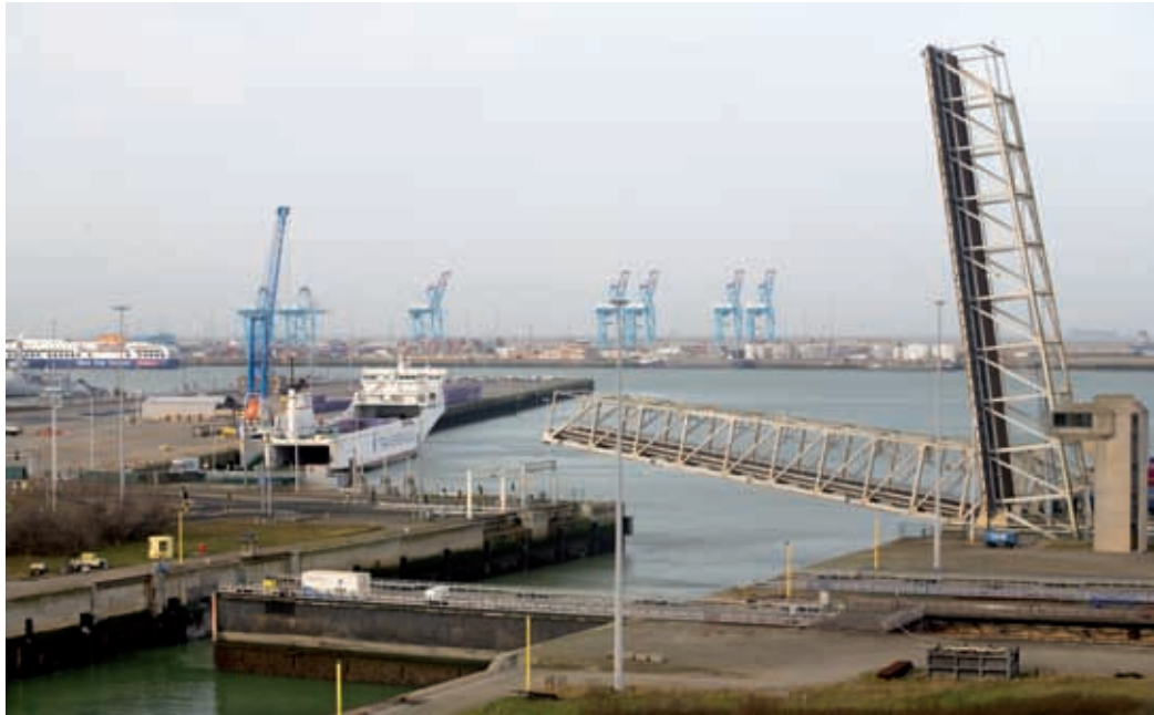
■ Op de zwart-wit beelden is te zien hoe de roldeur van de Van Dammesluis vlottend wordt aangevoerd en in de deurkamer geplaatst (afdeling Metaalstructuren). Het kleurbeeld toont een actuele weergave van de werking van de roldeur (cfr. horizontaal, deels naar rechts geschoven volume op de voorgrond (MD))
