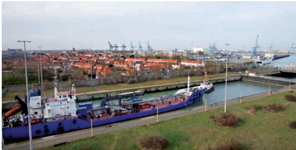
■ Zeesluizen, zoals hier de Pierre Van Dammesluis in Zeebrugge, stellen schepen in staat om veilig getijverschillen tussen de zee of haven en de achterliggende binnenwateren te overbruggen (MD)
