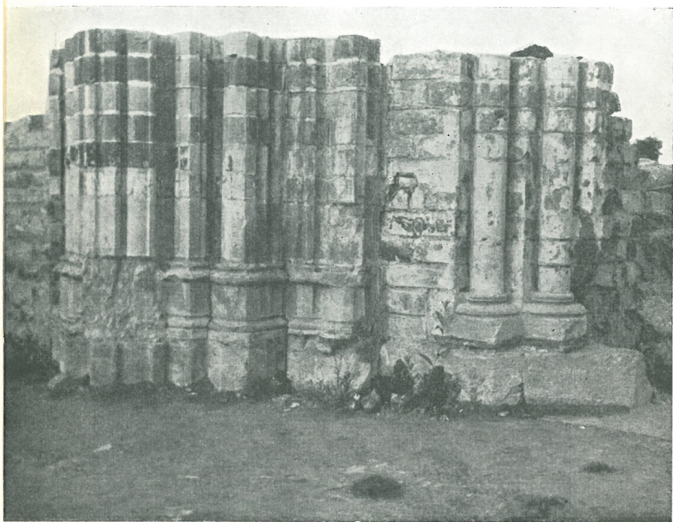
Voorportaal. Links : oostelijke pijlerbundel onder de noordelijke gordelboog. A. C. L. Rechts : flankerzuiltjes van de noordelijke kerkingang.
