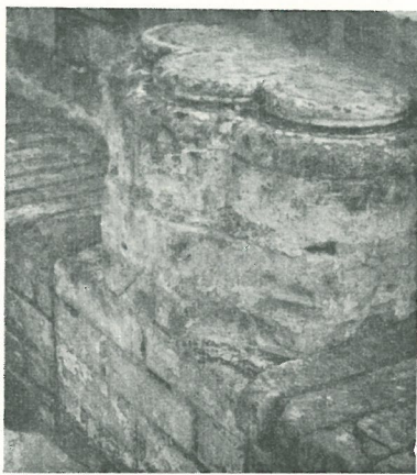
Basement van een pijlerbundel in de zuidbeuk.
