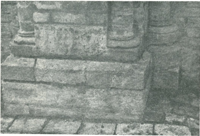
Basement van een pilaster tussen de beuken (westmuur).
