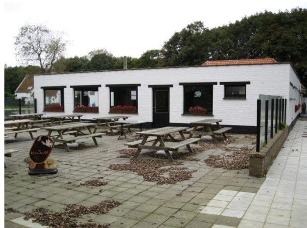
Gebouw met huidige cafetaria en pick-nick plaatsen
