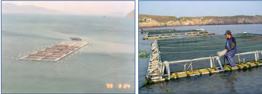
Fig. 10-13 - Luchtfoto van het offshore aquacultuurplatform in de Baai van Daya en een detail van een metalen frame viskooi.
