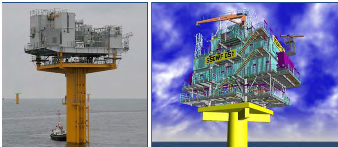
Fig. 10-6 - Substation Barrow Offshore Wind en kunstenaarsvisie van een substation bij het Sheringham Shoal wind farm voor the Norfolk coast.
