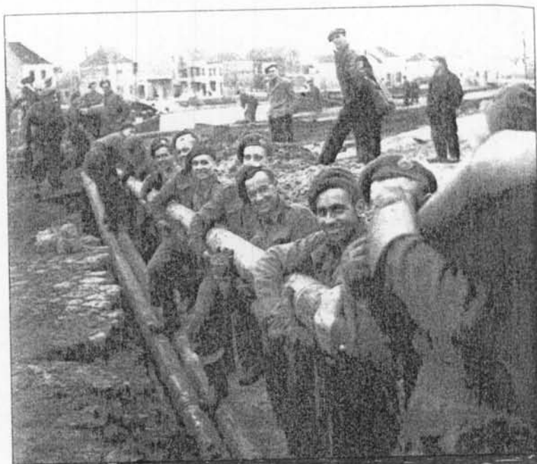
Fig. nr. 44? Haven Oostende, september/oktober 1944. Canadese geniesoldaten (Royal Canadian Engineers), bij de aanleg van de Dumbo-pijplijn op de aanlegsteiger aan het kanaal Oostende-Brugge, ter hoogte van het clubhuis van de roeivereniging RSNO (vulgo : "de Sport Nautique"). Het beginpunt van de pijplijn lag op de Diepwaterkaai (Cockerillkaai) te Oostende. In de achtergrond de Prinses Elisabethlaan te Bredene (Sas-Slijkens). Helemaal links de schouw van het visafvalverwerkingsbedrijf "Pescator", gelegen op het einde van de Prinses Elisabethlaan, (wordt aldaar "Brugsesteenweg"). Midden achtergrond, aan de Prinses Elisabethlaan, het bijhuis van de coöperatieve S.E.O. (Bijhuis Nr. 8), op de hoek van de Spaarzaamheidstraat.
