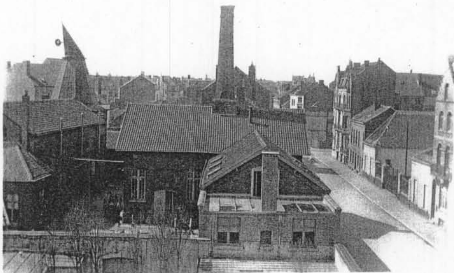
Moultoren en schoorsteen Warschaustraat
