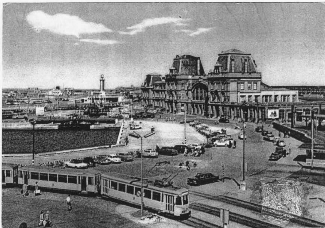
Fig. nr. 49. Oostende, omstreeks 1960. Zicht op het vergroot stationsplein, het spoorwegstation Oostende-Kaai en het oostelijk uiteinde van het Eerste Handelsdok. Men bemerkt duidelijk de nieuwe gedeelten kaaimuur en verharding, die gebouwd werden om de vroegere toegang tot het voormalig Brandarisdok en het stationsplein te vergroten. Bemerkt op de voorgrond het nieuw tramstation (1856) aan de Brandariskaai.
