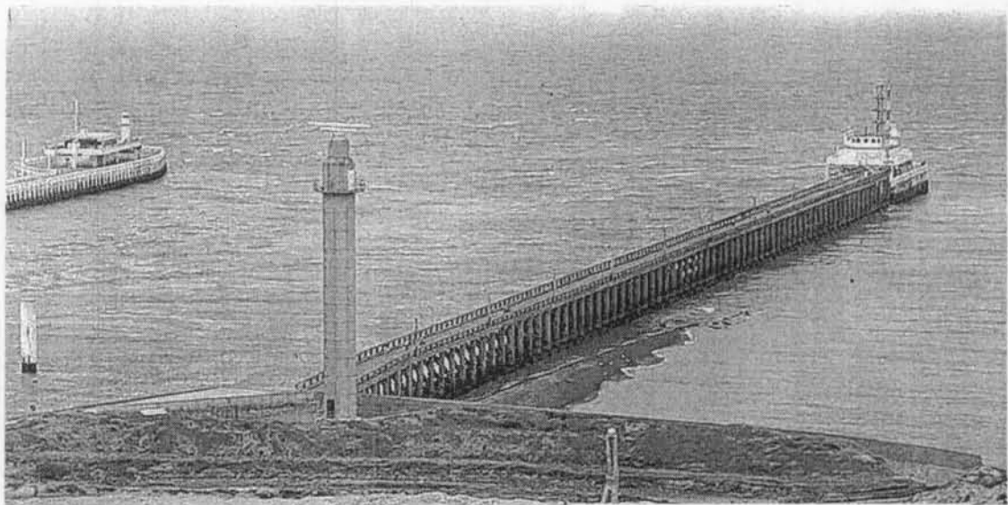
Fig. nr. 90. Het huidige betonnen oosterstaketsel, 2006. Zal gesloopt worden in de nabije toekomst.
