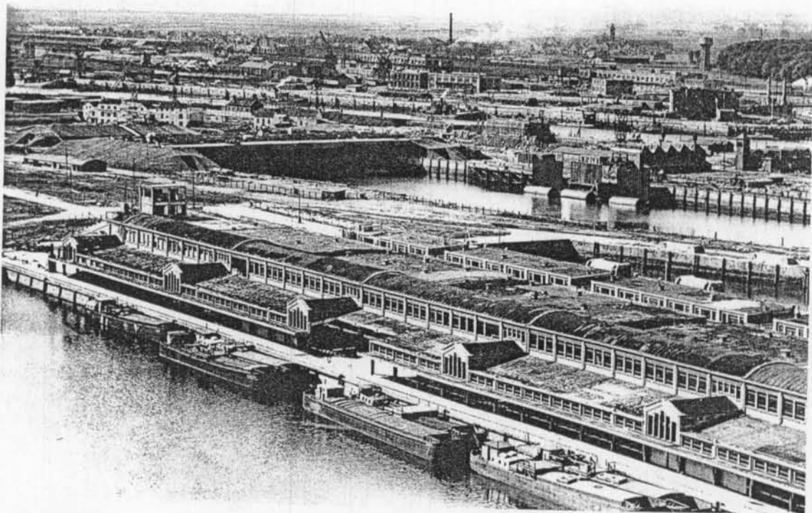
Fig. nr. 21. Haven van Oostende, 1942. Zicht vanaf de vuurtoren op het visserijdok (met vismijn), het tijdok, het Zeewezendok en de voorhaven. Aan de kaai in het visserijdok bemerkt men nog een aantal "Prahmen" (omgebouwde binnenschepen). Op het zuidelijk uiteinde van het Zeewezendok overspant de snelbotenbunker de volledige breedte van het dok. Een camouflagenet overspant het geheel van de bunkers. Aan de westelijke kaai muur liggen elementen van het vlottend scherm. Omheen het tijdok staan een aantal schuilplaatsen gebouwd door de Duitsers. In achtergrond aan de kaaien van de voorhaven zijn een aantal "Vorpostenboote" gemeerd.
