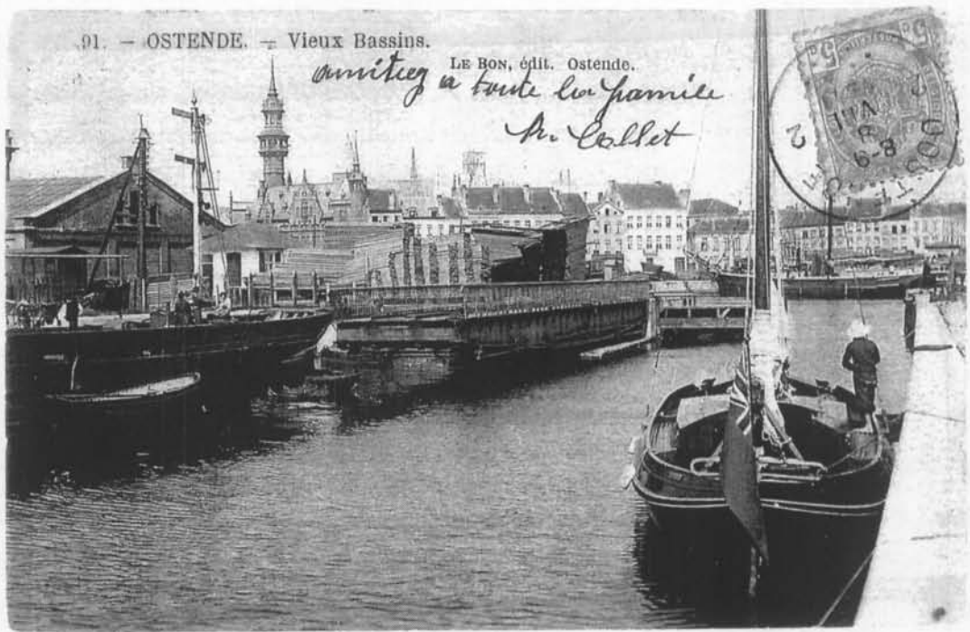
Zicht op het sluishoofd en op de opengedraaide stuwbrug waarover de spoorweg liep naar het eerste Zeestation. Let op de seinpaal voor de treinen, en deel van het openbaar stapelhuis en de houtstapels, ca. 1906
