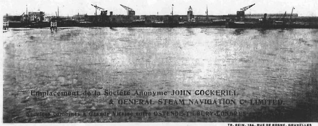
De diepwaterkaai ca. 1912 met de toenmaals vier nieuwe elektrische kranen en de grote hangaar, aanbesteed in 1908 en pas afgewerkt in 1911
