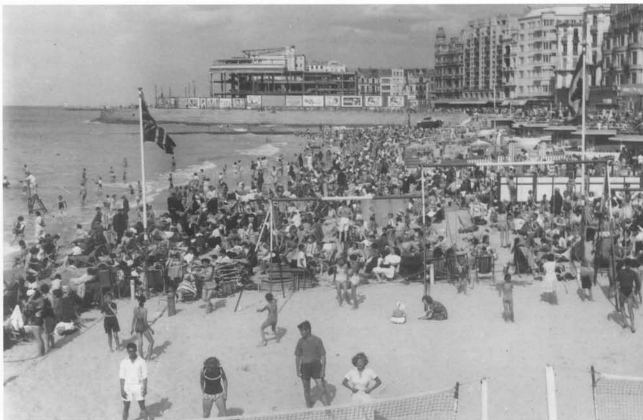
Het Kursaal in opbouw
