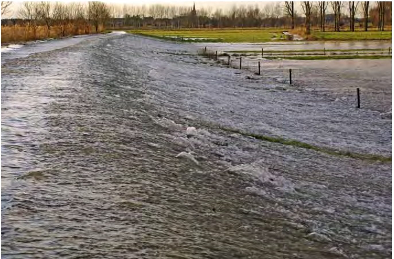
Bij springtij stroomt het Scheldewater over de overloopdijk in het overstromingsgebied. Deze extra ruimte voor het water beschermt de bewoonde valleigebieden tegen overstromingen.
