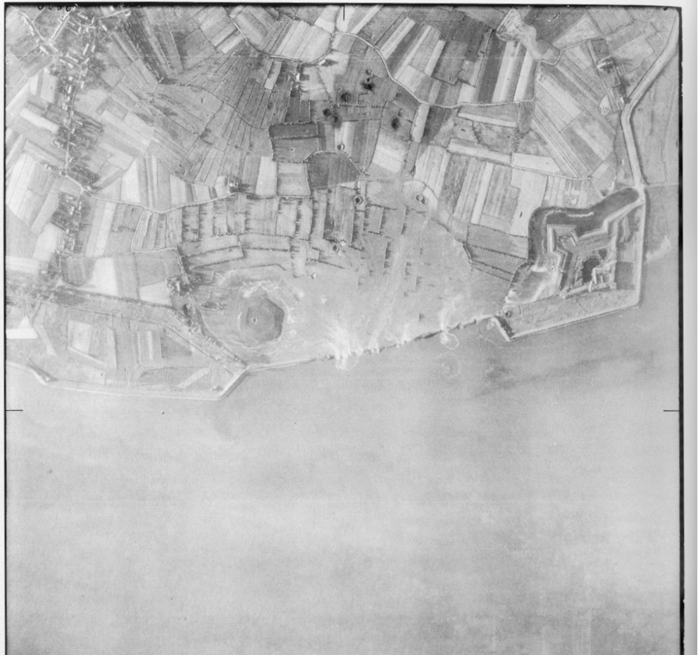
Figuur 5 : Luchtfoto na bombardement van de dijk nabij fort Rammekens
