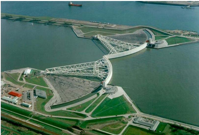
Figuur 4: Maeslantkering op de Nieuwe Waterweg, Nederland
