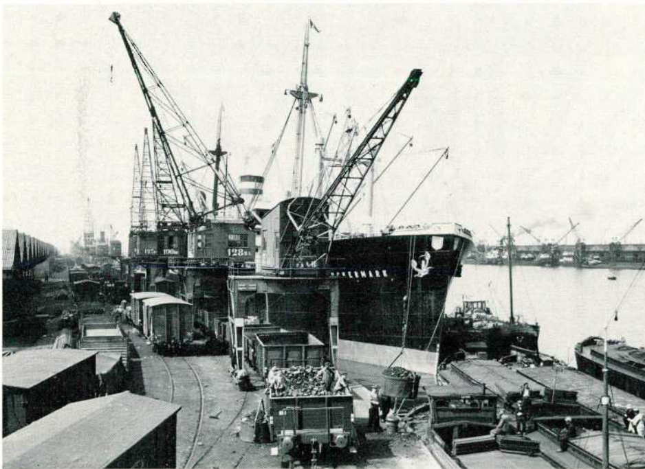
Tussen 1914 en 1945 doen stalen stoom- en motorschepen hun intrede, alsook de eerste traktoren. Verder verschijnen elektrische portaaltopkranen van 2,5 tot 8 t over één tot drie treinsporen, en de eerste elektrische laadbruggen van 15 t voor ertsen en kolen.
