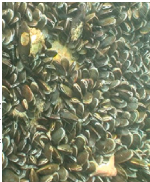
Aangroei op turbinepalen op 2 meter diepte.
