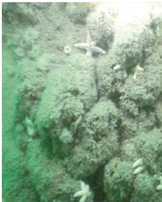
Aangroei op turbinepalen op 10 meter diepte.
