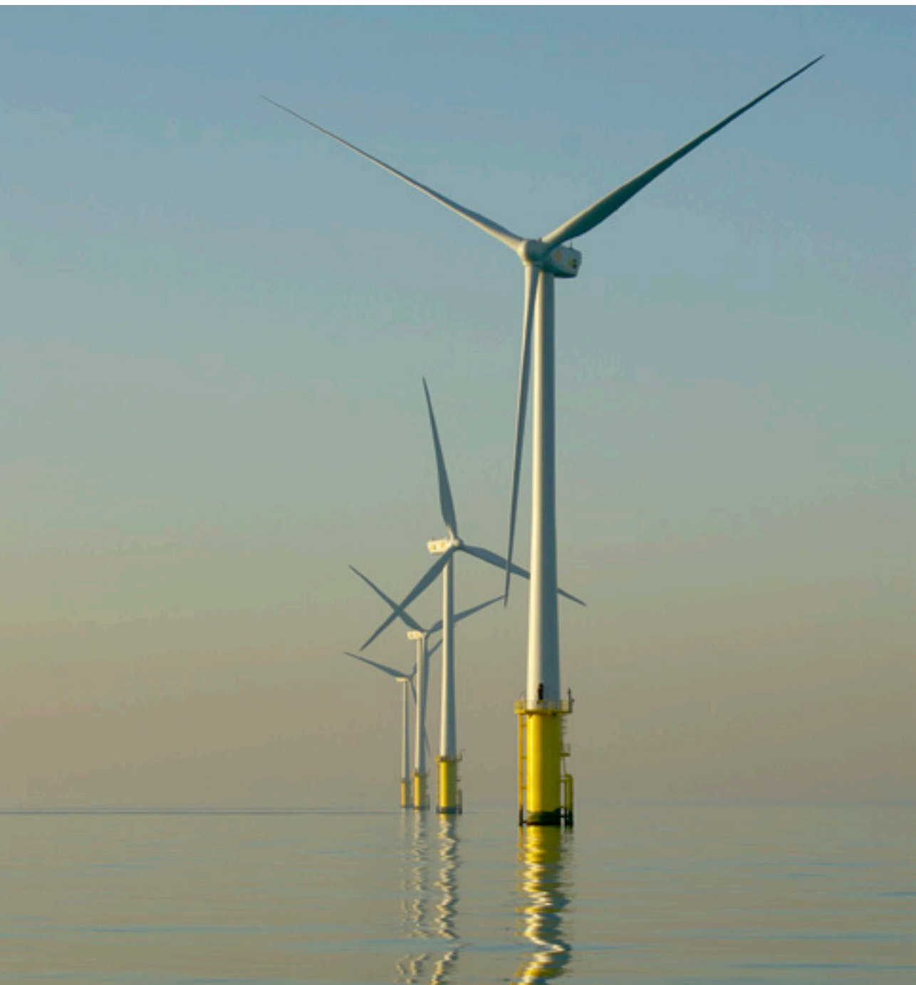
Het Offshore windpark Egmond aan Zee (OWEZ) is het eerste windpark dat in de Noordzee voor de Nederlandse kust is gebouwd. Het park bestaat uit 36 turbines met ieder een vermogen van 3 MW.
