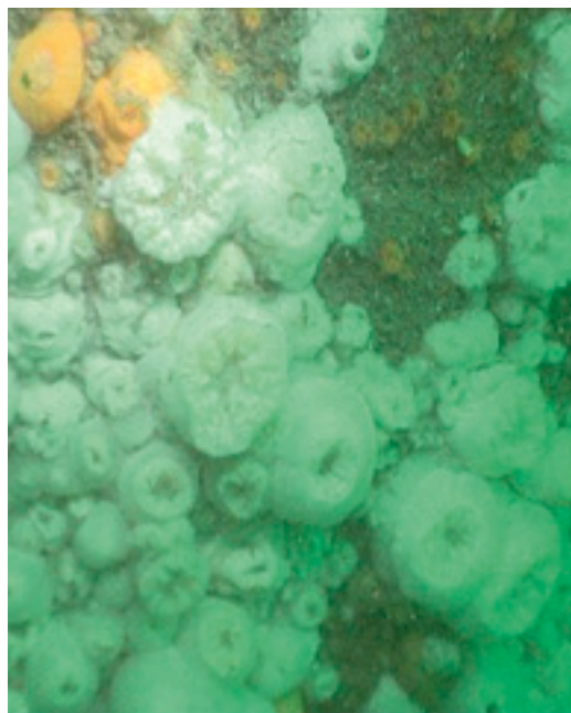
Aangroei op turbinepalen op 15 meter diepte.
