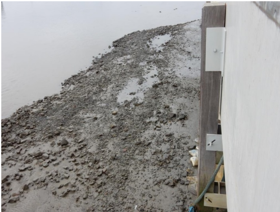
Figuur 2 – Detail van steenbestorting met zones met ongewenste erosie (putten)
