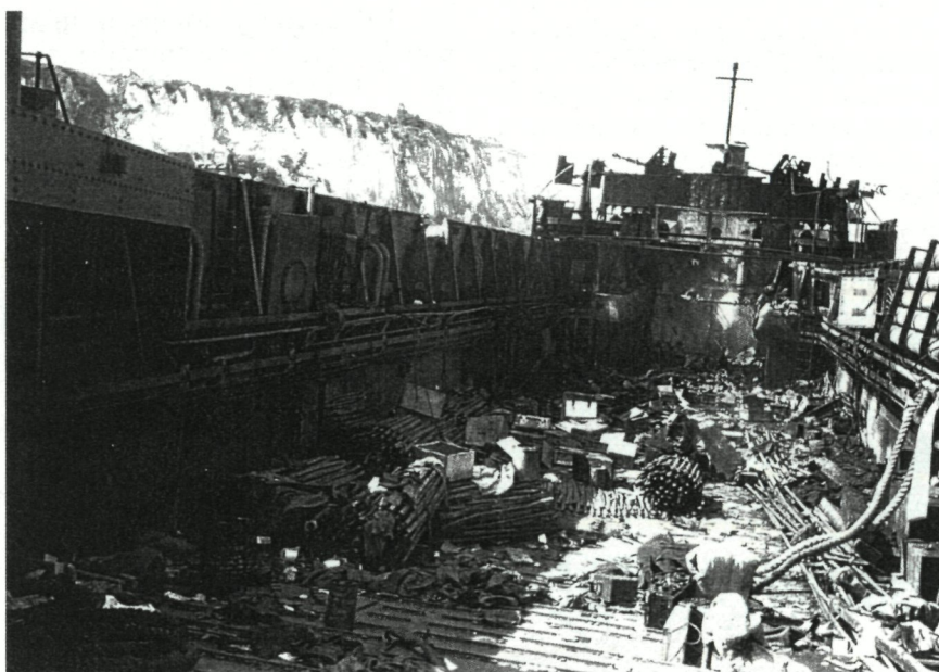
LCT n°3, passerelle et après déblaiement.
