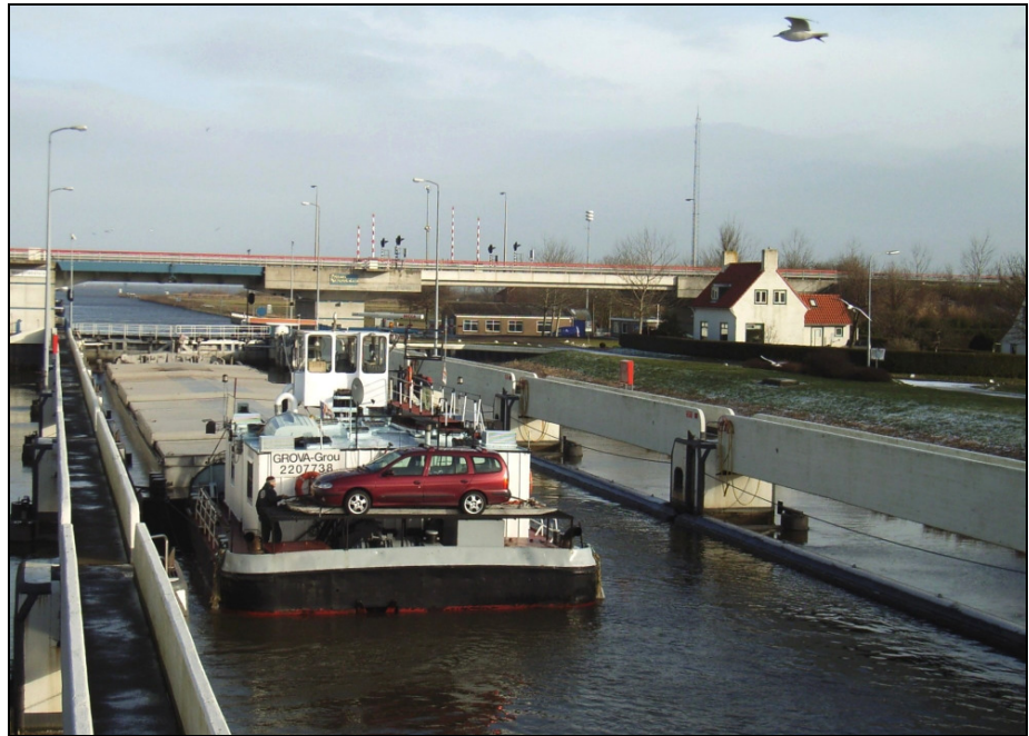
De Prinses Margrietsluis in Lemmer heeft een zogeheten groene kolk
