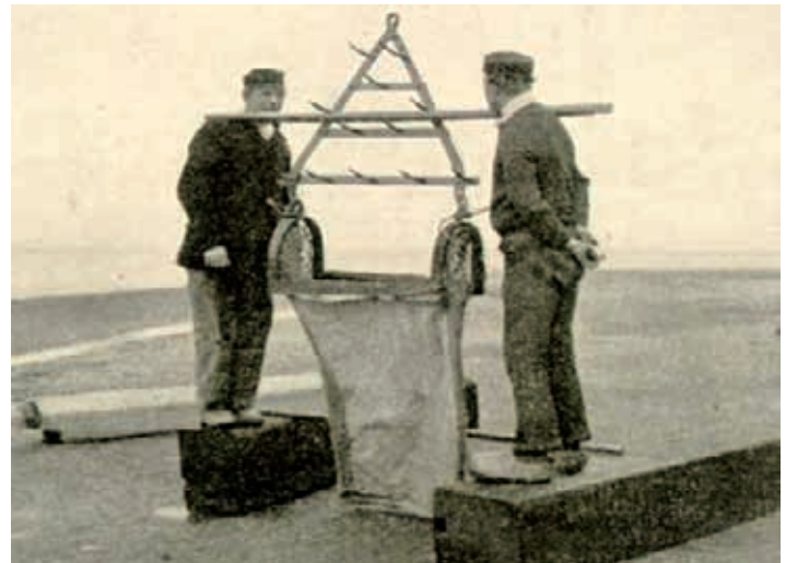
■ Het materiaal van Gilson voor het verzamelen van monsters: links een eenvoudig grijptoestel voor het nemen van stalen op zandige bodems en rechts een klein sleepnet speciaal ontworpen voor de staalname op ruwe bodems (KBIN)
