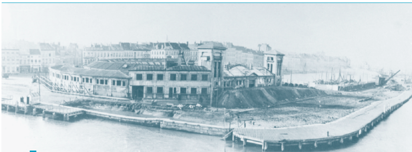
Unieke foto van de afbraak van de oude vismijn in februari 1938 (foto genomen door de aannemer belast met de afbraak)
