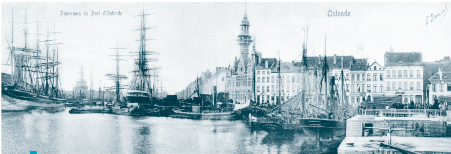
Panoramisch zicht op het Eerste Handelsdok, richting Kapellebrug en Tweede Handelsdok (omstreeks 1900). Uiterst rechts, de sluis die het Eerste Handelsdok met de havengeul verbond. Het gebouw met het spitse torentje is het Zeevaartcommissariaat (ook "pilotage" genoemd), dat ooit nog onderdak bood aan het Zeewetenschappelijk Instituut (ZWI) (uitgave V.G.)
